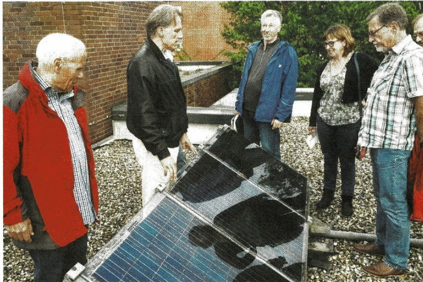
Bereits seit Jahren informiert Klimaschutzfonds-Vorsitzender Michael Koehn (Zweiter von links) Besucher über die Solaranlage auf dem Dach des Wedeler Rathauses. Deren Förderung läuft jetzt aus. Dem Fonds versiegt damit eine Einnahmequelle.
